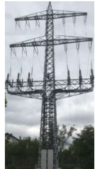
Fotomontage des benötigten neuen Kabelaufführungsmastes am Amselweg
